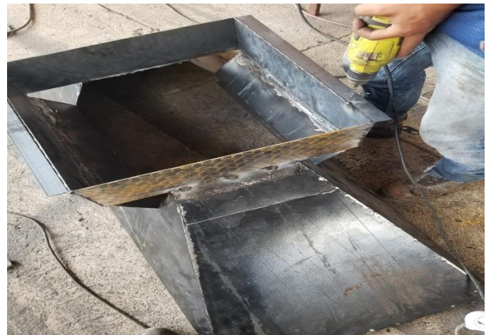
Figura 44 Aberturas con el taladro para los tornillos que se ajustan en la estructura
