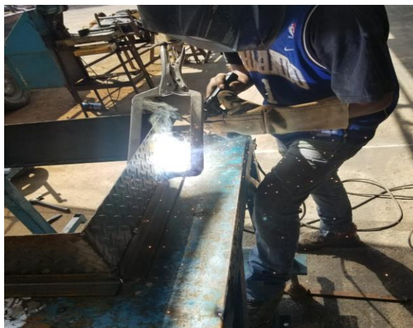
Figura 41 Aplicación de soldadura en cada lado de la caja de cuchillas
