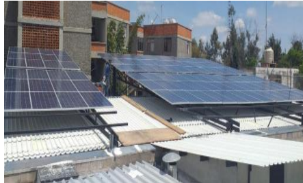
Figura 2 Instalación de paneles solares
