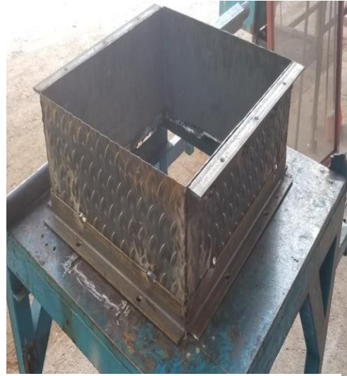
Figura 39 Construcción de la caja de las cuchillas
