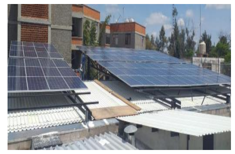
Figura 9 Instalación de Paneles solares
