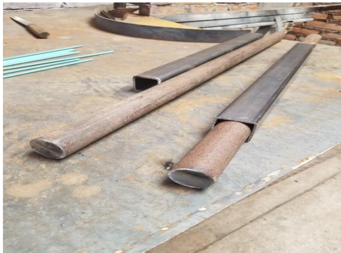
Figura 48 Construcción de los ejes Rotatorios
