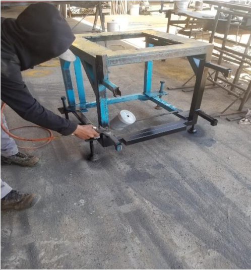
Figura 50 Aplicación de la primera capa de pintura
