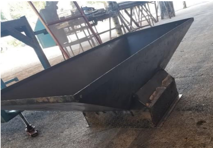
Figura 45 Construcción de la tolva
